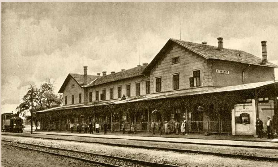
Az 1944. október 31-én felrobbantott régi vasútállomás épülete (PSVK HGY)
