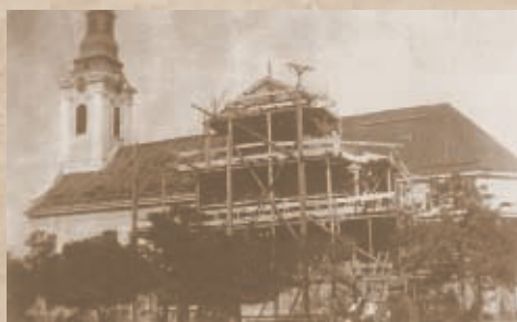
A katolikus templom kereszthajójának építése 1931-ben (PSVK HGY)
